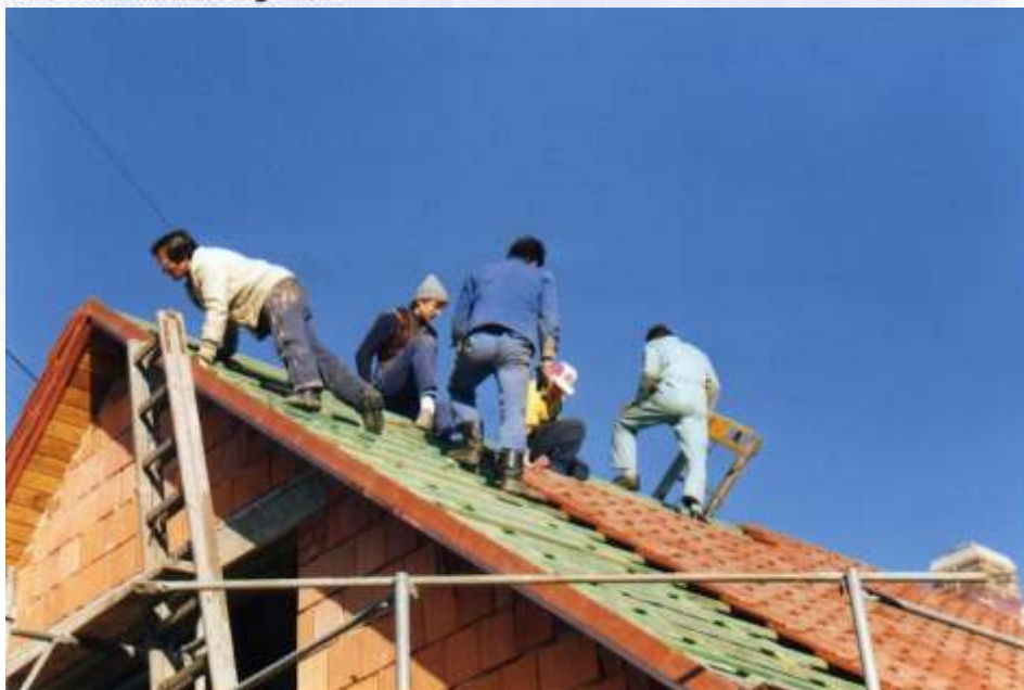
Die letzten Handgriffe, dann ist der Bau wasserfest.
